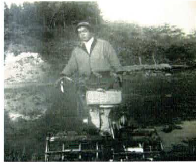
テラー：水田車輪を付けての代掻き。
