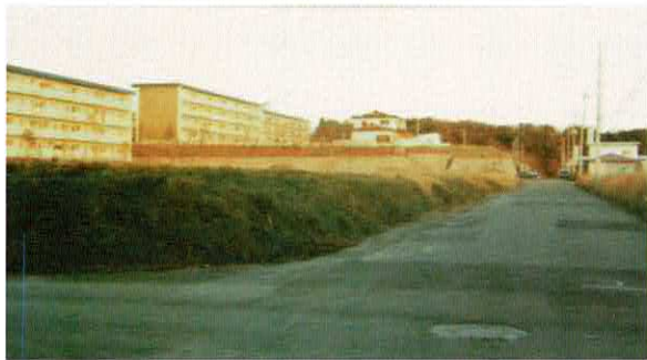
県営松崎住宅：昭和50年に団地の北部の土地を秋田県住宅供給公社に譲渡した。51年に着工開始し、54年までに10棟を完成させた。現在250世帯。
