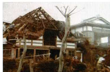
茅葺き家の解体風景：昭和50年代。
