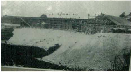
旧下北手小学校の校舎建築中の写真。
